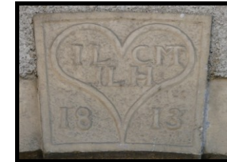
Rue du Merelez 3
