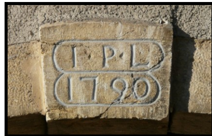
Rue du Merelez 4
