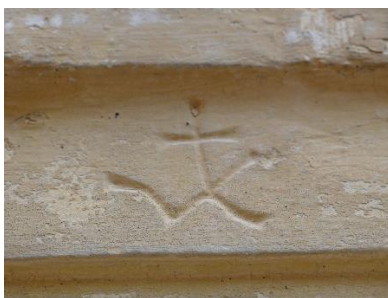
Signature d'un tailleur de pierres sur le porche d'entrée, 1605
